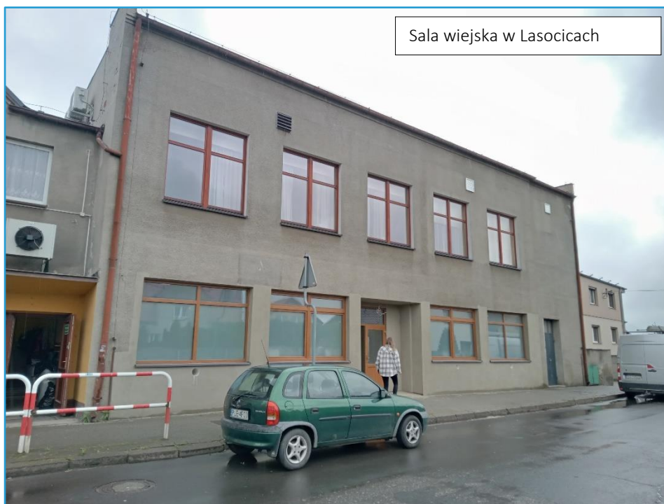
Rycina 19 Przykłady budynków w złym stanie technicznym zlokalizowanych na obszarze rewitalizacji
