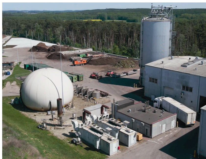
Zakład Zagospodarowania Odpadów Trzebania 15
