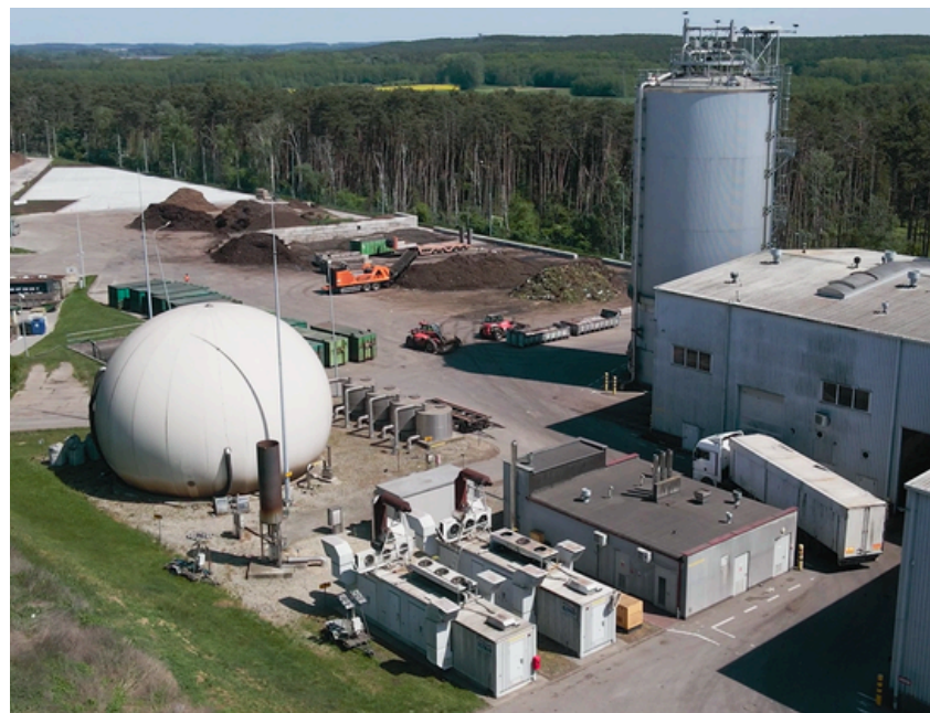
Zakład Zagospodarowania Odpadów Trzebania 15
